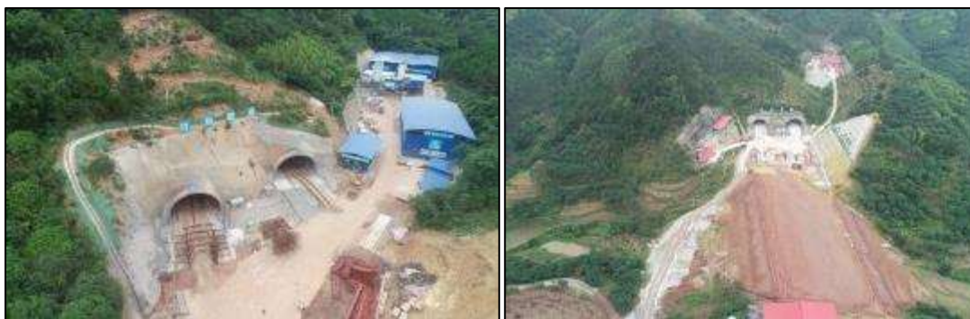
图2.5-1 河阳隧道进出口现状
