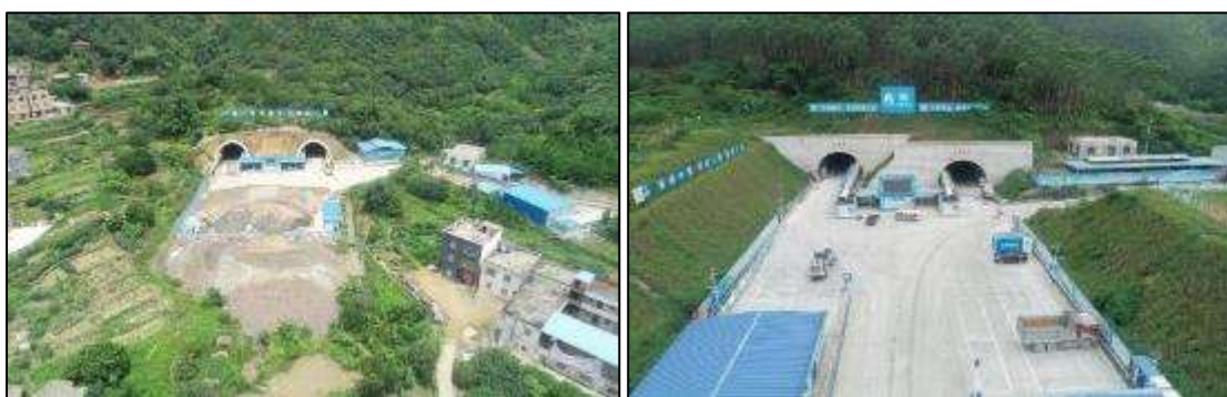
图2.5-3 平田隧道进出口现状
