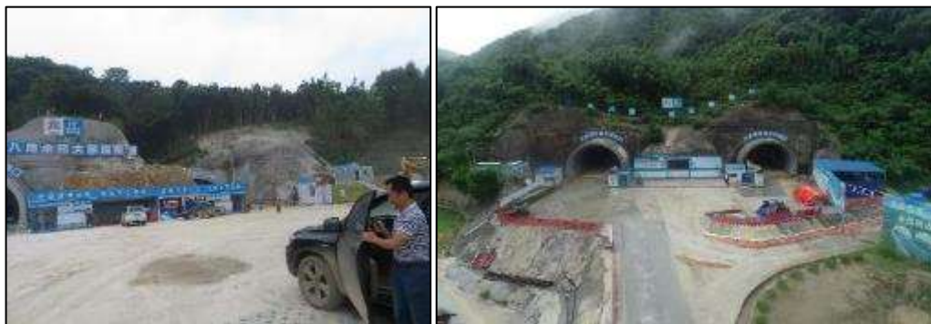
图2.5-4 大茅垌隧道进出口现状
