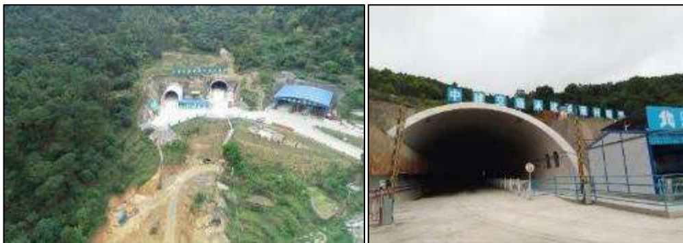
图2.5-2 罗屋村隧道进出口现状
